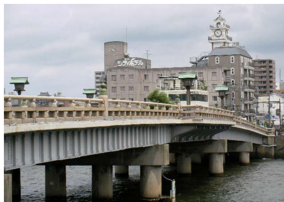
図3 現在の松江大橋
