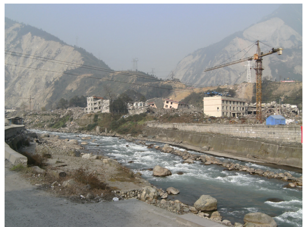
写真—5 映秀の町の被災状況
