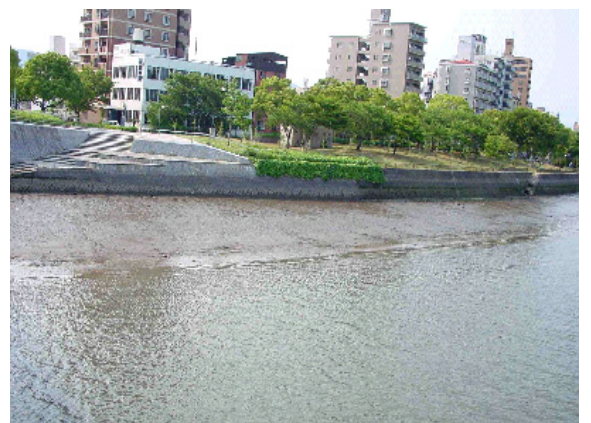
写真-1 京橋川における泥の堆積状況
