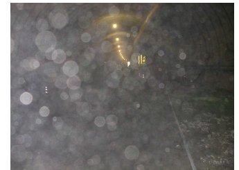
写真-1 トンネル坑内での撮影
