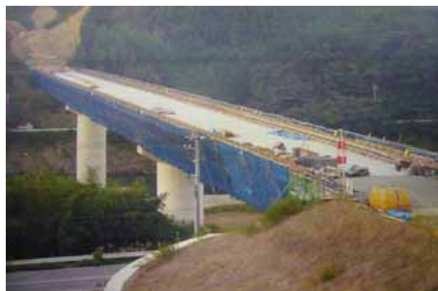
写真1 三径間連続鋼コンクリート橋
