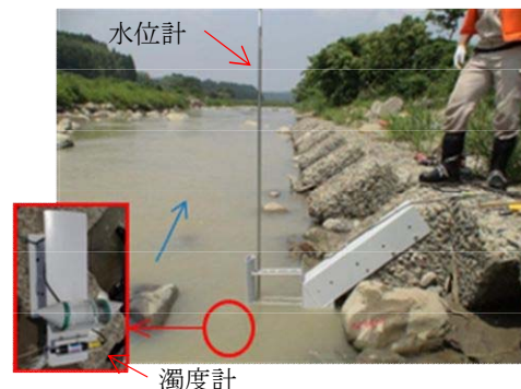
写真-2 観測機器設置状況
