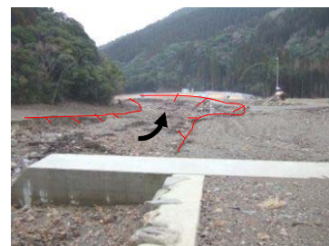
写真－4 治山えん堤下流のガリー浸食
