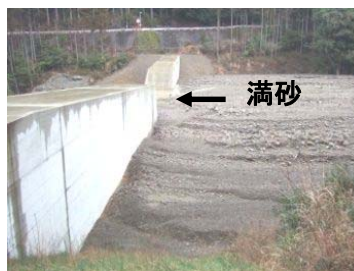
写真－3 砂防えん堤の満砂状況 (H19 年完成)
