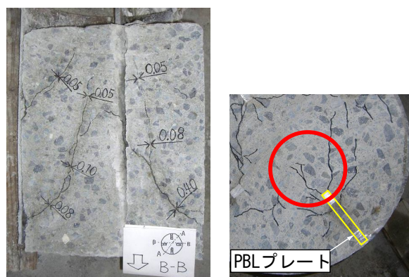
Photo.2 ひび割れの状況
