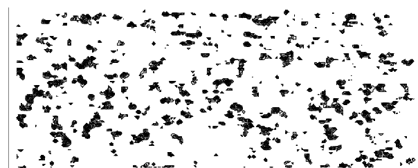
Fig.4 塗膜劣化状態 50 年経過 (黒い部分が鋼露出部)
