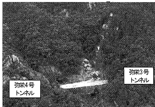
写真-3 東側斜面の状況（広島県写真）
