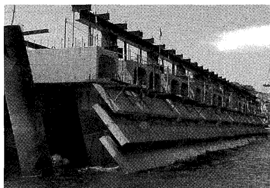
写真-1 音戸漁港工事中の写真
