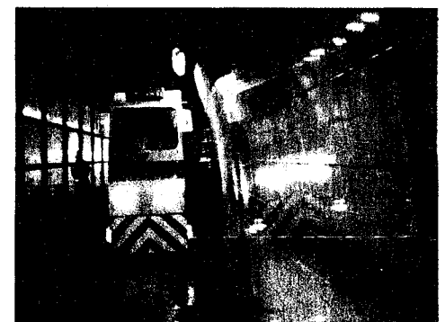
休山トンネル清掃試験状況
