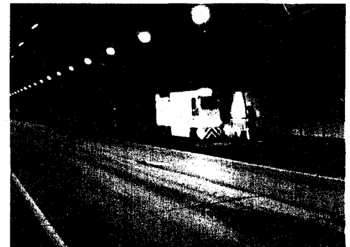
根之谷トンネル清掃試験状況
