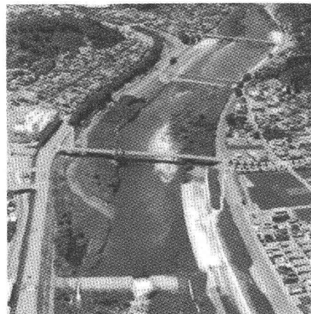
図－1 河川空間（簀上橋周辺）
