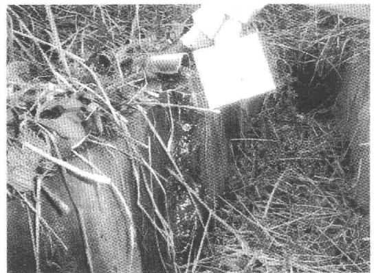
写真 - 1 集水管孔口のスライム
