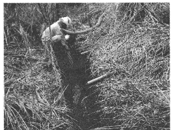
写真-5 集水管の洗浄作業
