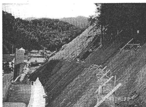
写真-1 斜面全景写真
