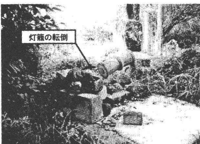
写真-1 灯笼の転倒状況 (番田稻荷神社)
