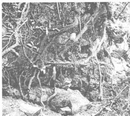
写真-1 根系による岩盤の脱落防止 (美祿市荒川)
