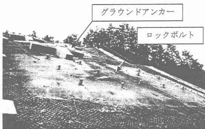
写真-1 補強土工の施工（現場 B）
