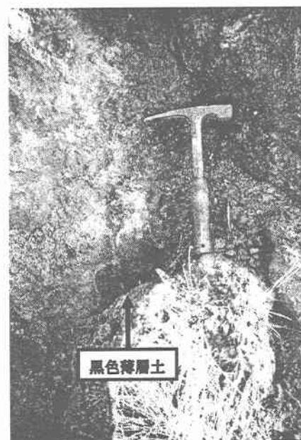
写真-2 すべり面に見られた黒色薄層土
