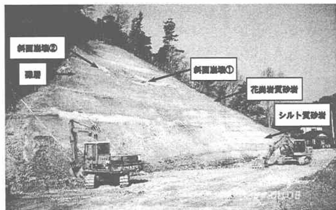
写真一1 現場の全景写真
