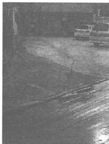
写真-1 地点 A の液状化
