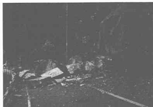
図-3 国道 432 号線での落石による被害
