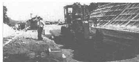
写真-1 試験施工による敷き均し状況
