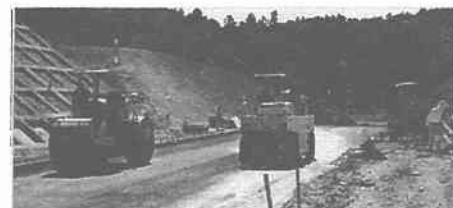
写真-2 試験施工による転圧状況
