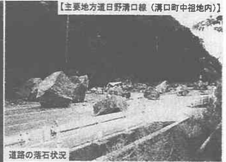
写真-2 落石の氾濫・到達範囲状況 到達距離は斜面直下より最大 30m、大部分は 15m 位までに停止する。（鳥取県写真）
