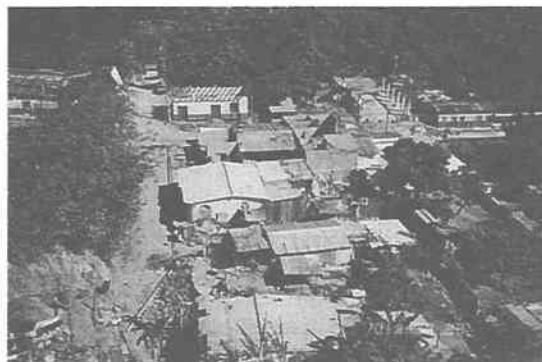
写真-5 Tepecoyo 斜面崩壊と倒壊家屋
