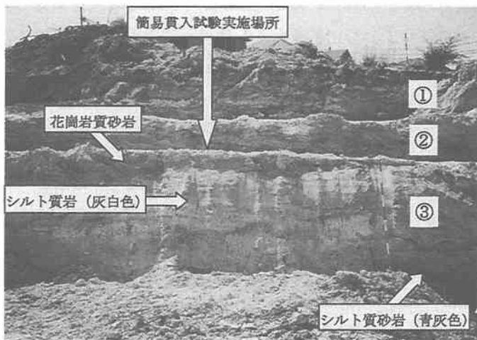
写真-2 現場の近景および簡易貫入実施箇所
