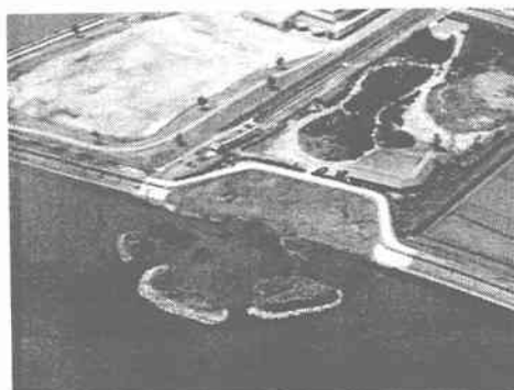
写真-1 湖岸堤状況写真
