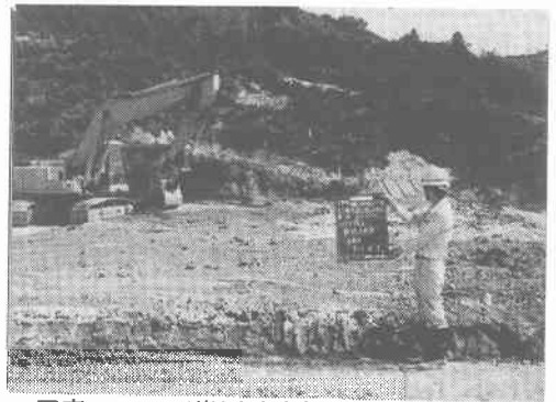
写真-1 石炭灰改良施工状況
