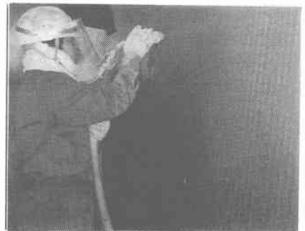
図-5 ポリマーモルタル吹き付け
