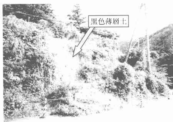
写真-1 県道64号線沿いの萩市飯井の崩壊斜面
