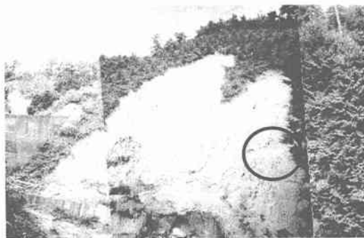
写真-1 広島市における斜面崩壊
