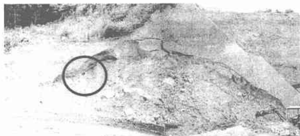
写真-2 東広島市における斜面崩壊
