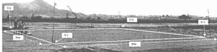
写真 1. 阿知須試験施工現場
