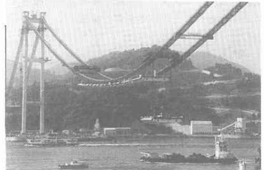
写真－3 桁の直下吊り架設
