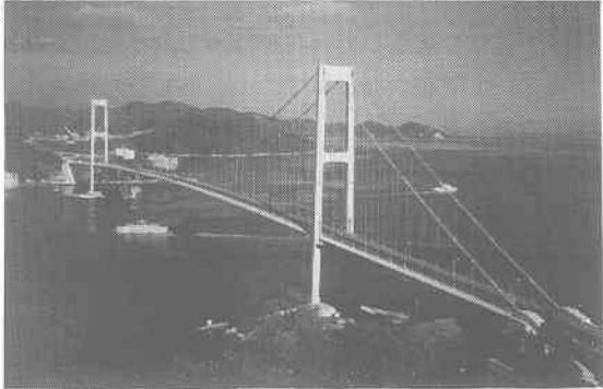
写真－1 安芸灘大橋の完成
