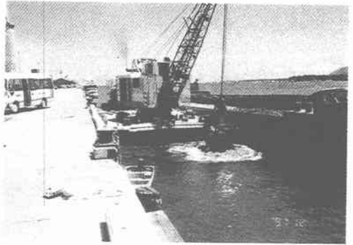
写真-3 ケアンズ港の浚渫
