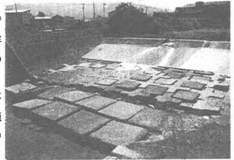
写真-1 調査を実施した堰
