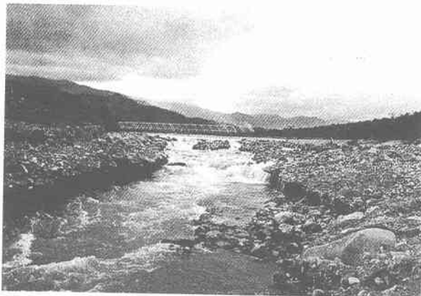
（平成2年台風19号による出水後）
