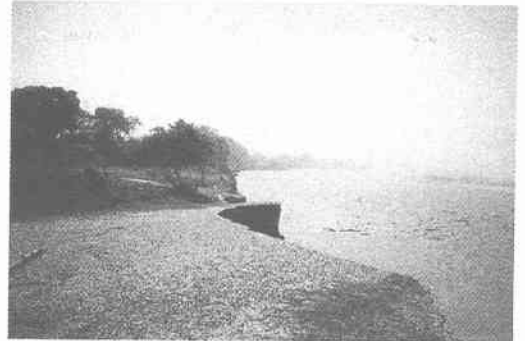
写真-1 グランデ川左岸で洗掘により道路が消失
