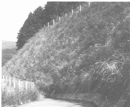
吹き付け後 1 年の近景
