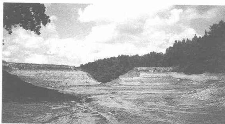
写真一1 麻生溜池の決壊状況
