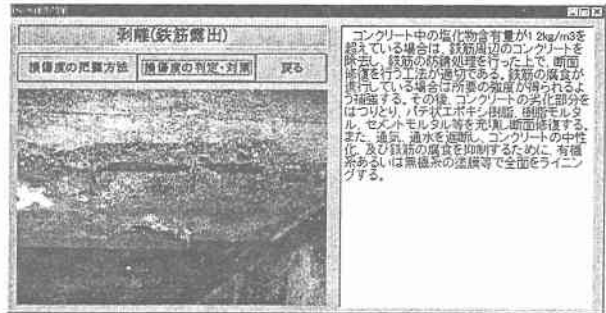
図5 損傷に対する対策の表示画面例
