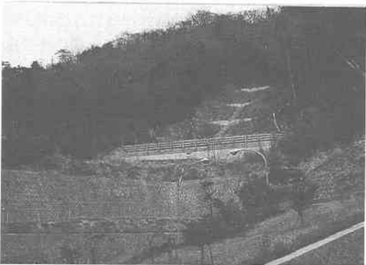
写真－1 斜面の現況
