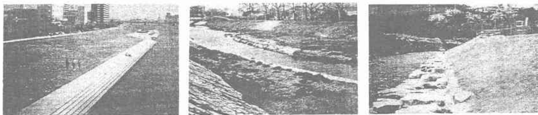
図-1 アンケートに使用した護岸写真の例
