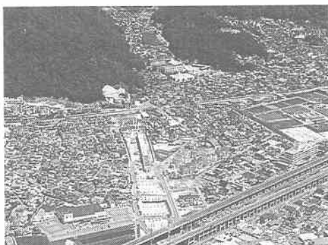
写真-1（終点側坑口周辺の状況）
