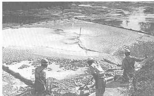
写真—2 スカム回収状況
