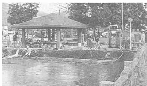
写真一3 HMA工法実験状況
