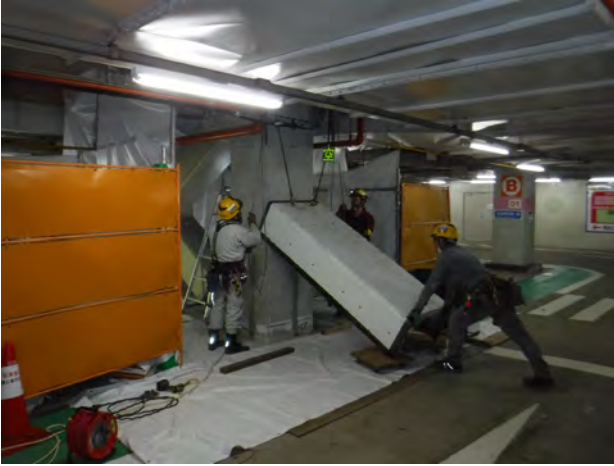
写真-1 鋼板補強組立て状況（地下街駐車場柱 B2F）
