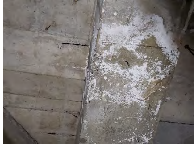
写真-4 漏水対応の状況①
