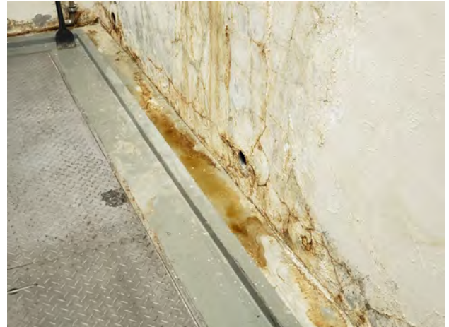
写真-6 漏水対応の状況③
