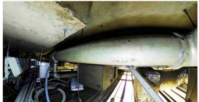
写真-17 地下街天井内の撮影状況
