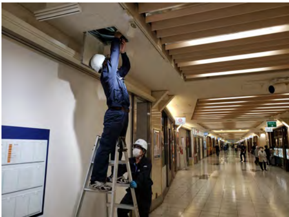
写真-15 地下街内の点検・保守状況
