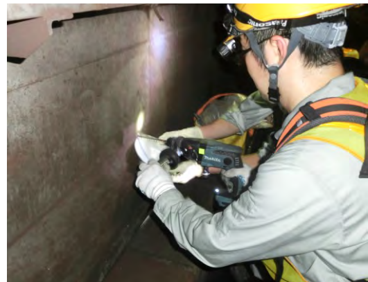
図-4 調査状況の例（ドリル法） 9)
