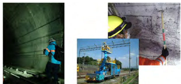
(目視調査) (打音調査)
