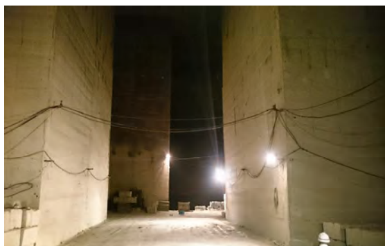
図-4 A 空洞内部の様子
