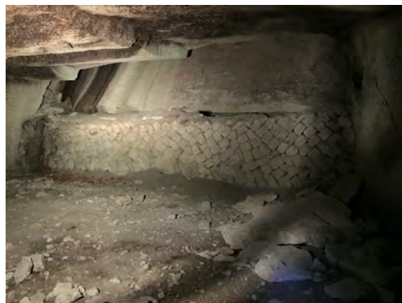
図-7 B 空洞3つ目の空洞内部の様子
