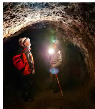
図-6 B 空洞2つ目の空洞内部の様子
