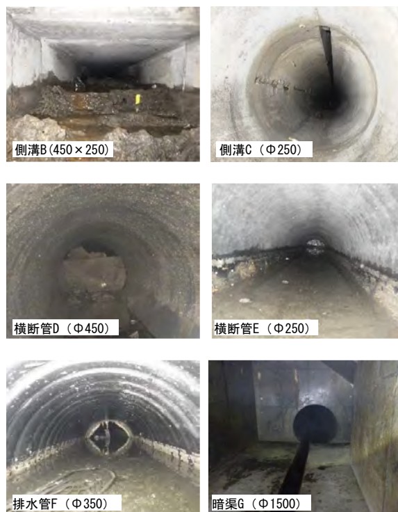
写真-2 排水施設の内部状況
