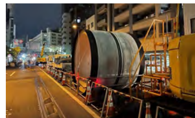
写真-4 路上作業状況
