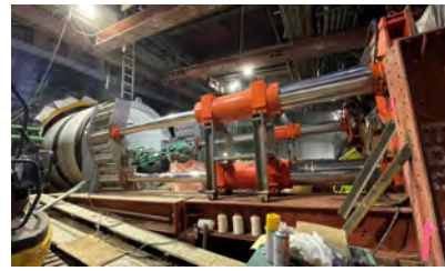
写真-3 推進架台
