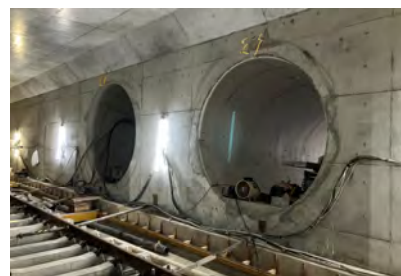
写真-5 推進管設置完了
