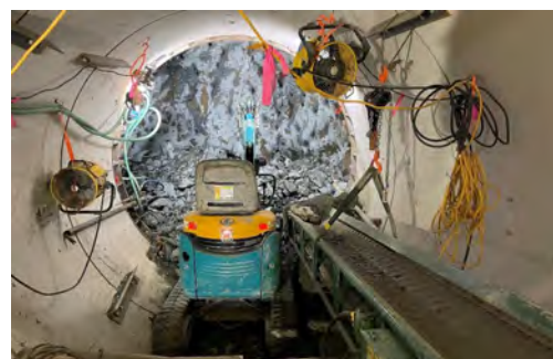
写真-2 推進状況
