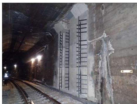
写真-17 施工状況（ケーブル配管用アングル）
