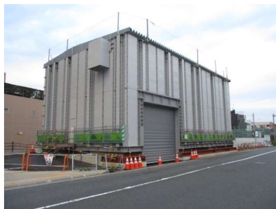
写真-9 防音ハウス外観
