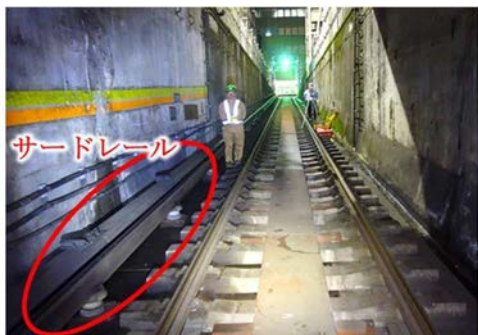
写真-15 サードレールの状況（上野通路線）
