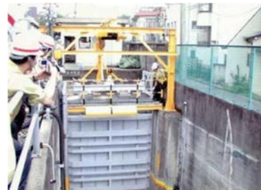
写真-4 丸ノ内線中野通路線坑口防水ゲート
