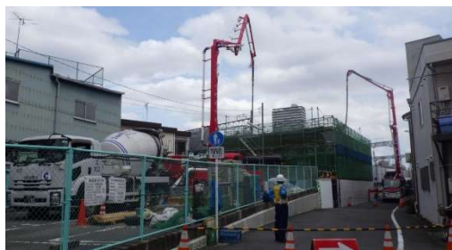
写真-18 施工状況（防水ゲート上屋コンクリート打設）
