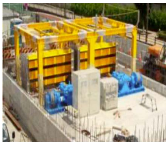
写真-7 北千住坑口防水ゲート設置状況
